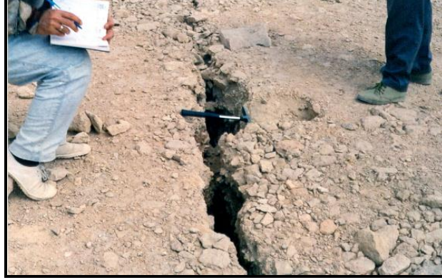
صورة (١٤): شق في الهضبة العليا قرب انهيار حديثم ن طريق الكورنيش في الاتجاه شرق - غرب
