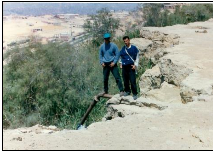
صورة (٨): تسرب المياه خلال الفواصل المتعامدة من ماسورة صرف صحي ساعد علي نمو نباتات كثيفة وتراجع لحافة الهضبة العليا الجنوبية عام ٢٠١٤
