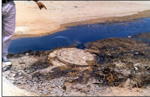
صورة (٥): تسرب المياه من الترنشات إلى داخل الشقوق والفواصل بشيخة منشأة ناصر بهضبة المقطم
