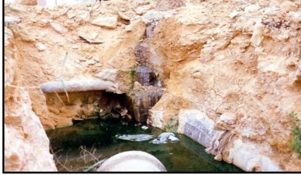
صورة (٣): تسرب مياه الصرف التي تحتوي على أحماض عضوية من الترنشات بحافة الهضبة العليا بشيخة المحاجر
