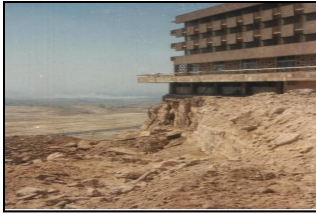
صورة (١٦): إنهيار الصخور أسفل الركن الجنوبي الغربي من فندق المقطم وقد ظهر معلقاً في الهواء
